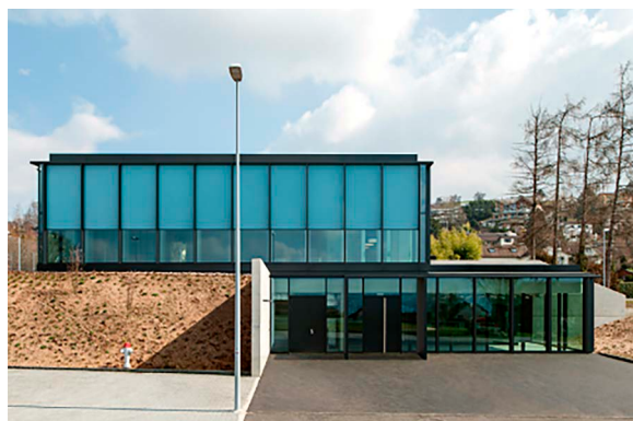
Abb. 2: Ansicht Süd-West Fassade.
