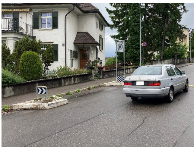
Abbildung 10 Lerchenbergstrasse – Fertigbauelemente in Tempo-30-Zone
