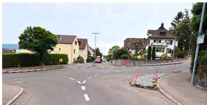
An der Drusbergstrasse stehen Bauarbeiten an.
